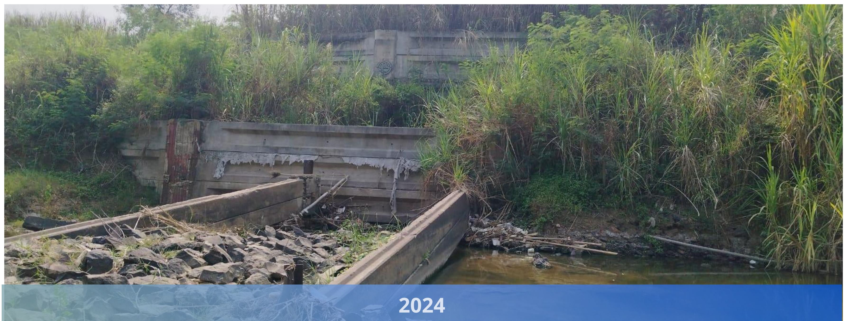
DPT borepile 1 tahun konstruksi
